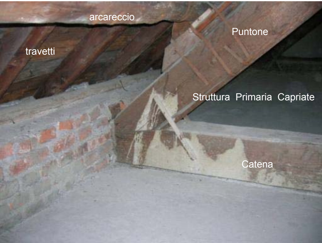
CAPRIATA ALLA LOMBARDA EDIFICIO A SOTTOTETTO
